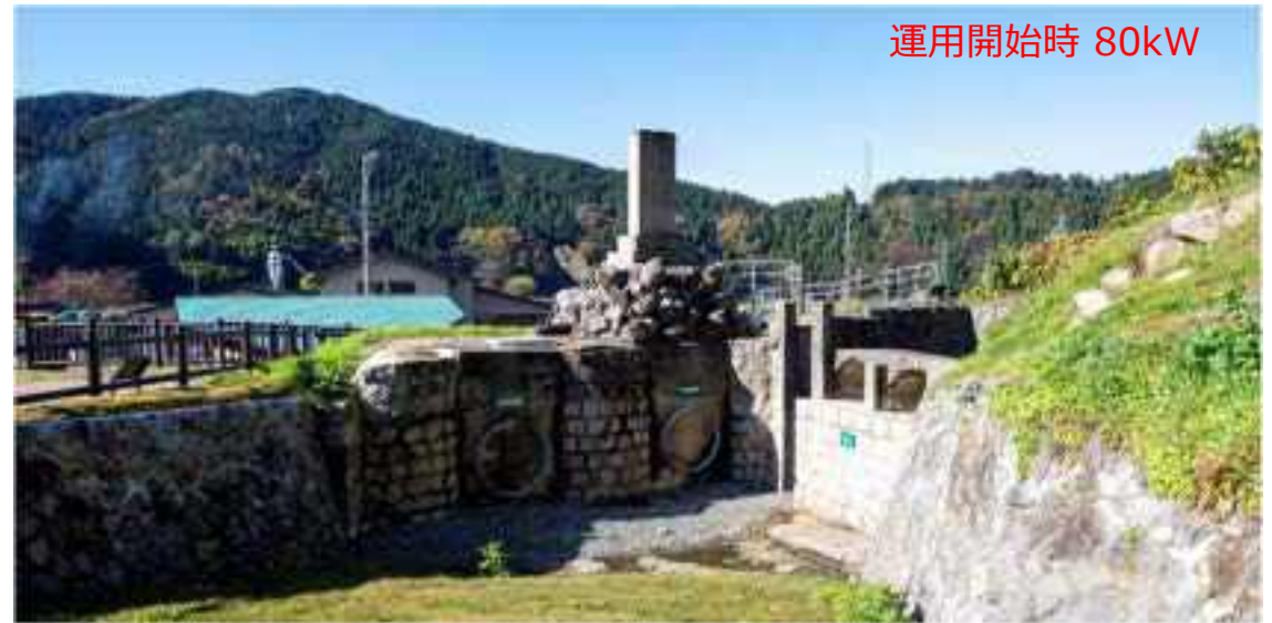
宿布発電所跡公園 ※当社初の請負工事（発電所稼働：1899～1956年）
