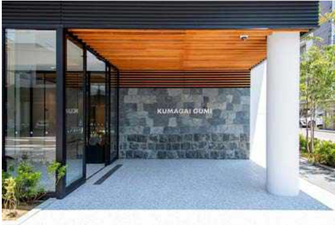
宿布発電所跡の石を割り付けたエントランス
